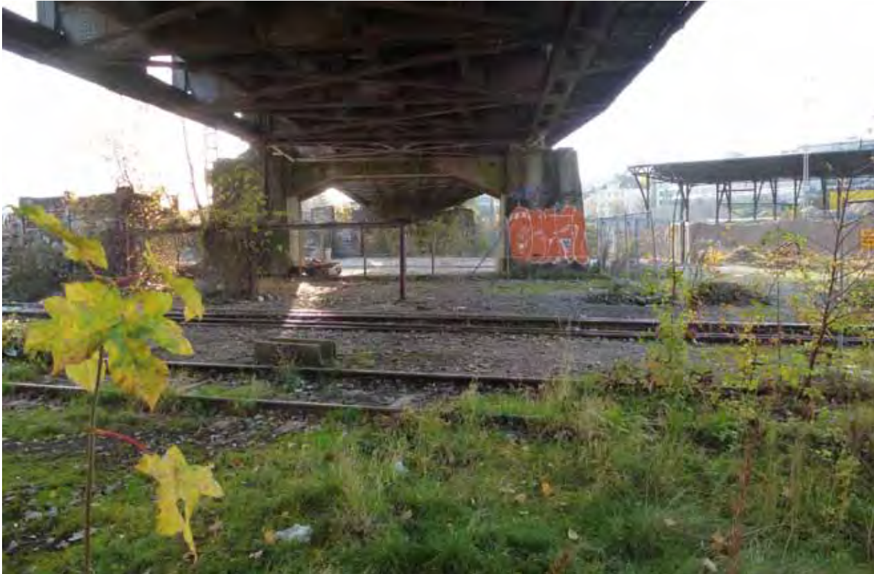
101 Der Raum unter der Stahlfachwerkbrücke über dem Inneren Nordbahnhof (Zustand 2012)
